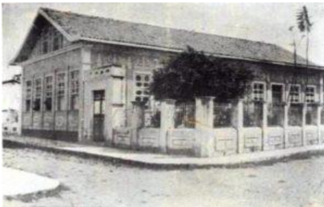
Figura 08: Casa do Sr. Antonio Alexandrino Filho, antigo Caiçara Clube.
