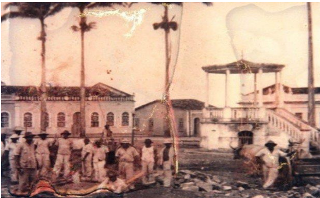
Figura 38: Antigo Coreto na Praça barão de Santa Rosa, homens cosntruindo o calçamento.
