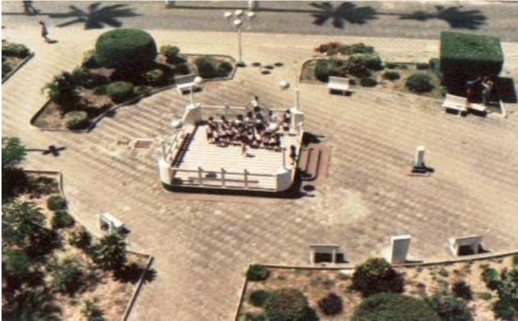
Figura 39: Visão aérea do Coreto se cobertura na Praça Barão de Santa Rosa, em uma das suas versões mais bonitas.
