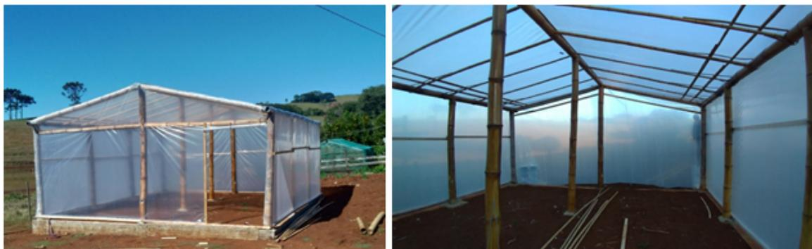
**Figura 4: Estufa modular de bambu, vista externa e interna em Itapejara do Oeste - PR**
