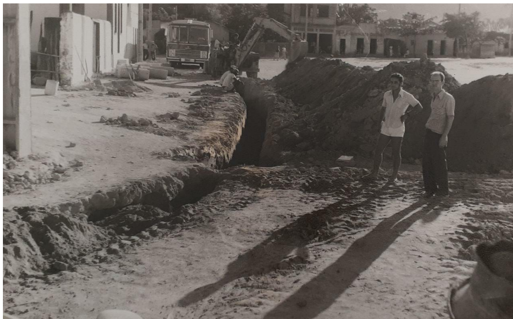
Fonte: 1977. Belo Oriente. Pe. Américo Magalhães da Fonseca (1918-1993), à esquerda e de calça comprida, junto a cidadão local acompanhando a instalação de rede de esgotos na cidade.
